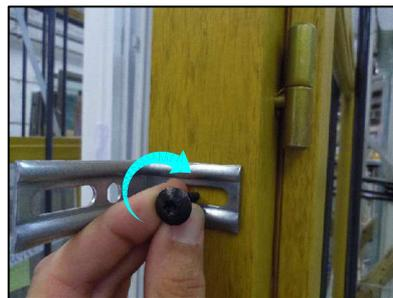
Placer la vis de 30 au milieu du trou oblong (pour garder une possibilité de réglage) puis visser avec un embout *Torx*.
